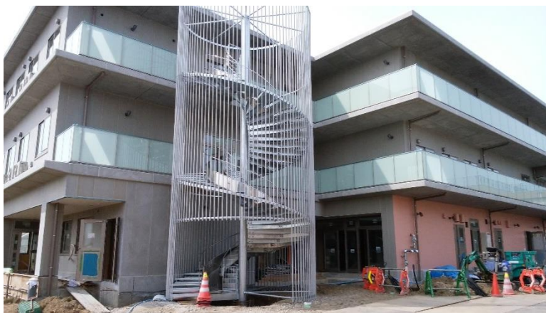
工事現場の防護幕が外れて、建物の外観が姿を現しました！
