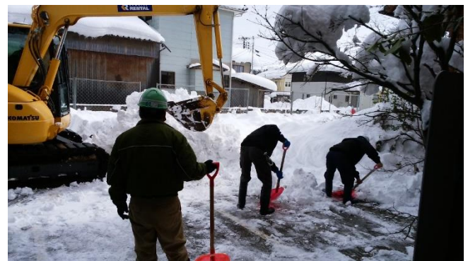
細かいところは手作業で除雪
