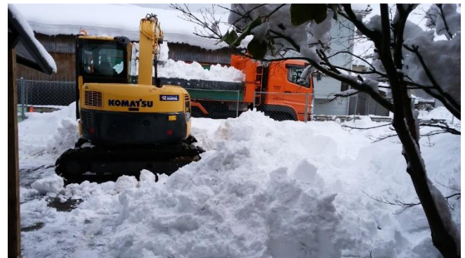
除雪車を使用している作業の様子
