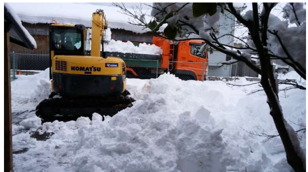
除雪車を使用している作業の様子
