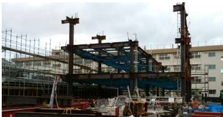
だんだんと建物の鉄骨が組みあがってきています。
